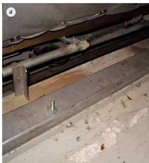
Рисунок 5.44. а) выдув изоляции из патрубка; б) схема мест продувов
