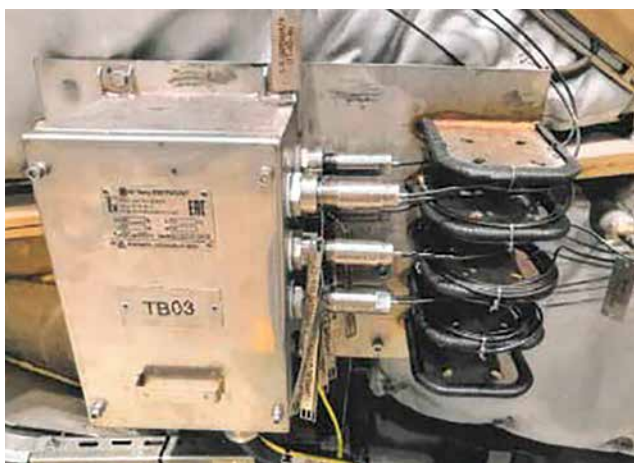
Рисунок 5.48. Улучшенный вариант крепления клеммной коробки
