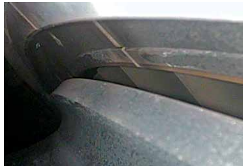
Рисунок 5.39. Смещение наружного переходного патрубка вниз (наработка 17 503 часа)
