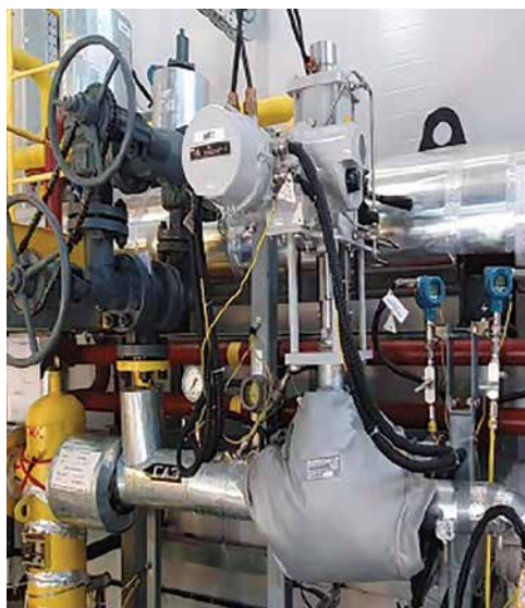
Рисунок 5.76. Регулирующий клапан топливного газа
