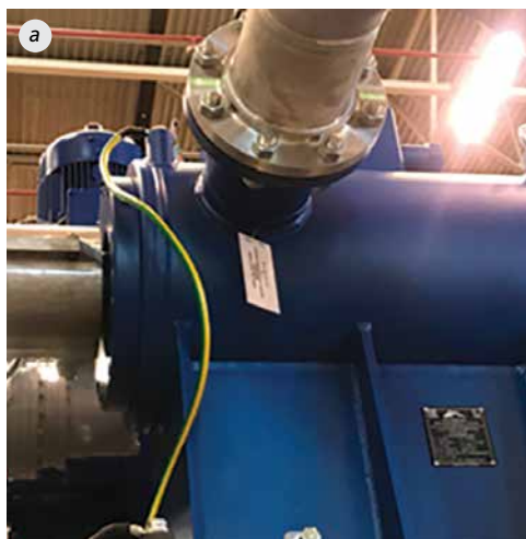
Рисунок 6.46. Главные масляные насосы: а) иностранного производства; б) отечественного производства
