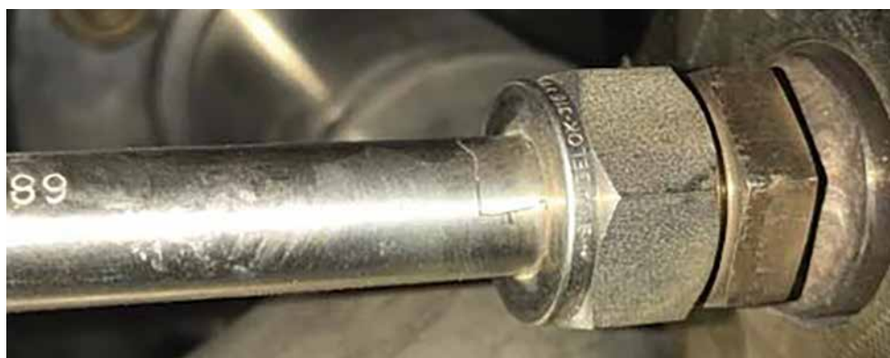
Рисунок 5.14. Трещина в районе закрепления воспламенителя в свече зажигания
