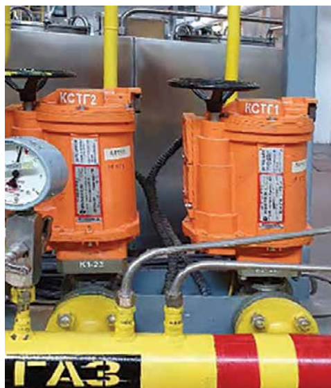
Рисунок 5.77. Стравливающие клапаны топливного газа
