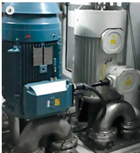
Рисунок 6.47. Аварийный и вспомогательный маслонасосы: а) иностранного производства; б) отечественного производства
