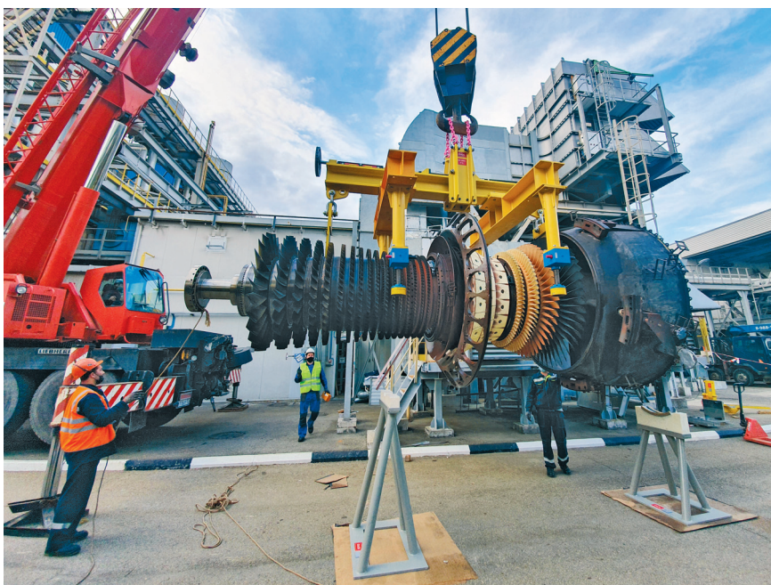
Рис. Демонтаж газовой турбины для выполнения ремонта в условиях предприятия
